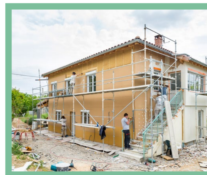
Rénover les bâtiments
