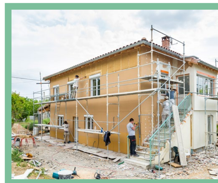
Rénover les bâtiments
