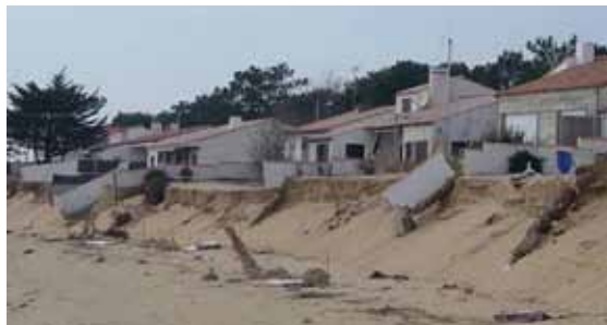
Recul du trait de côte à la Tranche sur Mer (Vendée) ayant causé l'endommagement de maisons situées en première ligne.
