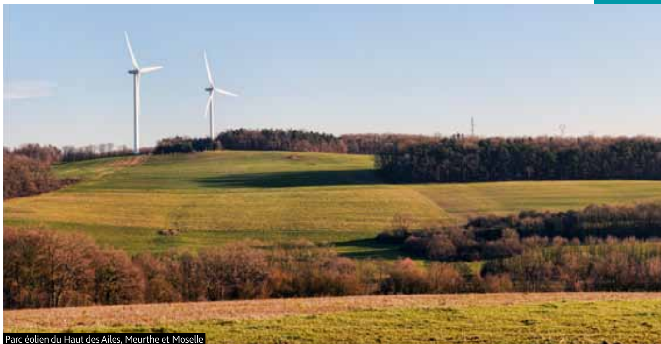
Parc éolien du Haut des Ailes, Meurthe et Moselle
