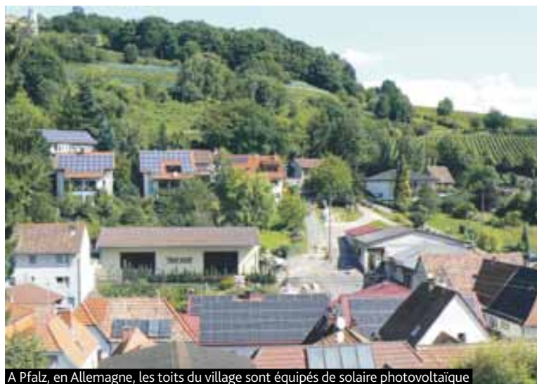
A Pfalz, en Allemagne, les toits du village sont équipés de solaire photovoltaïque
