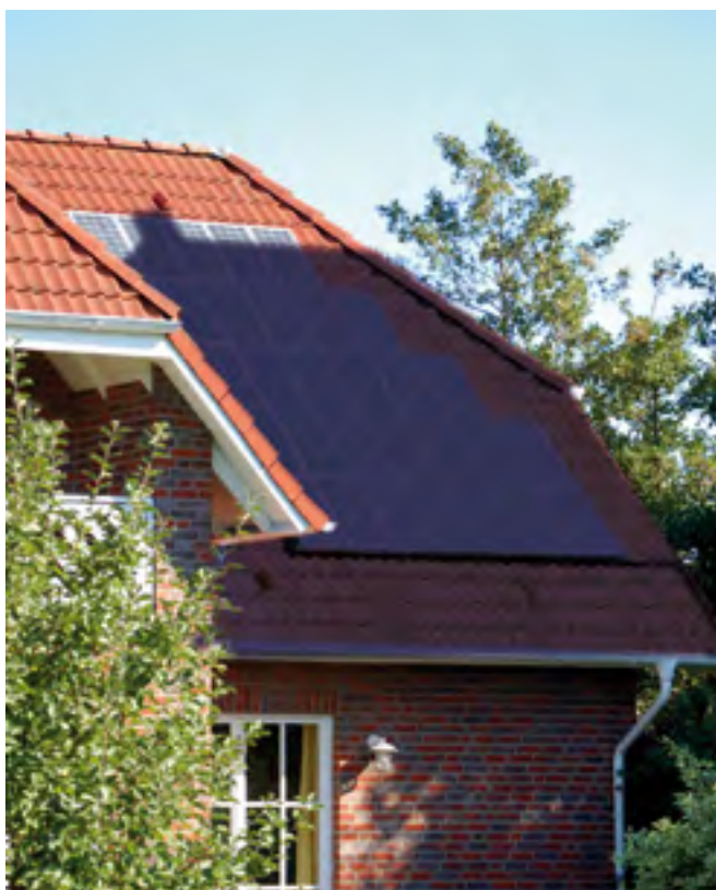
Installation de panneaux photovoltaïques dans l'ombre
